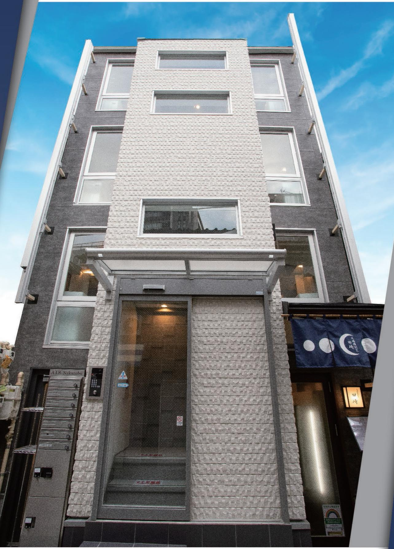
鉄骨造ピンブレース構造で
